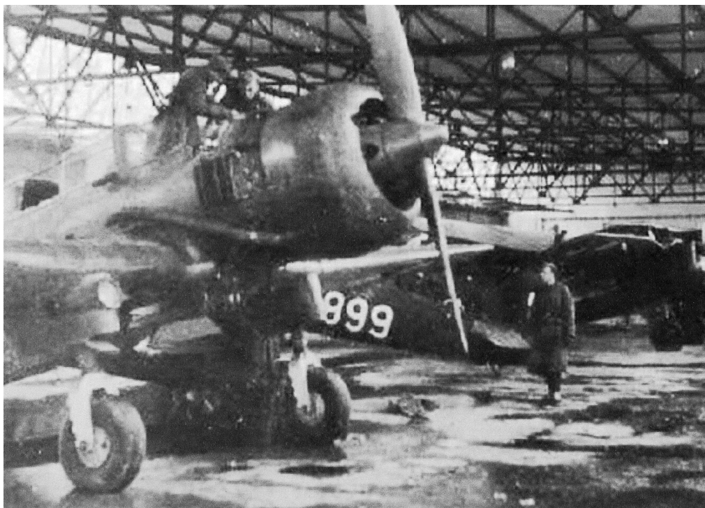
Hala montażowa GSL wykorzystywana przez Niemców do naprawy zdobycznych samolotów polskich. Na pierwszym planie remont PZL.23 „Karaś”. (TJK)
