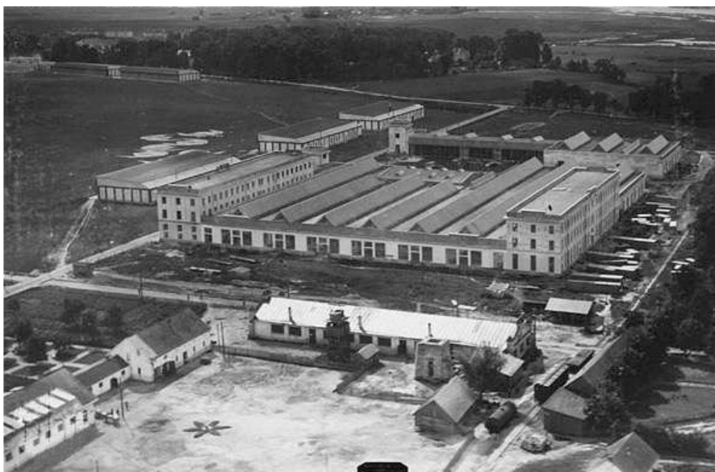
W centralnej części zdjęcia główny budynek hali montażowej GSL, z lewej hangary nr 5, 6 i 7. (RM)
