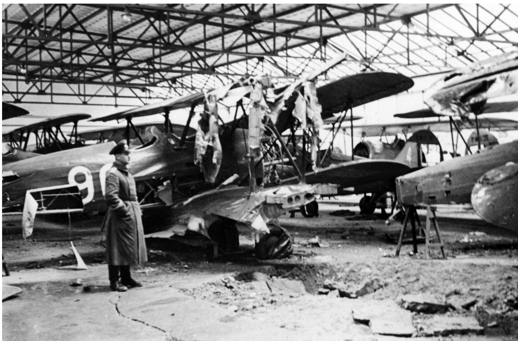
Samoloty PWS-26 w hali montażowej GSL. (TJK)
