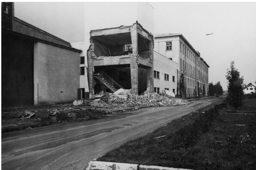
Od lewej końcówka hali GSL, zniszczona klatka schodowa i Dział Nauk. Niemcy przebudowali klatkę schodową i urządzili warsztat remontowy samochodów. (TJK)
