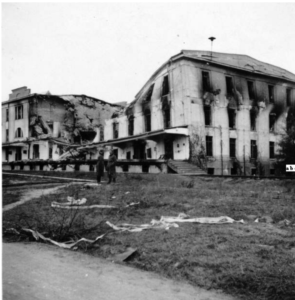
Zbombardowane hale magazynowe G-SL z rampą kolejową - podjazd torami kolejowymi od strony rzeki Irenka, między obecnymi WZL-1 a szpitalem. Niemcy odbudowali magazyny, które istnieją do dziś. (TJK)
