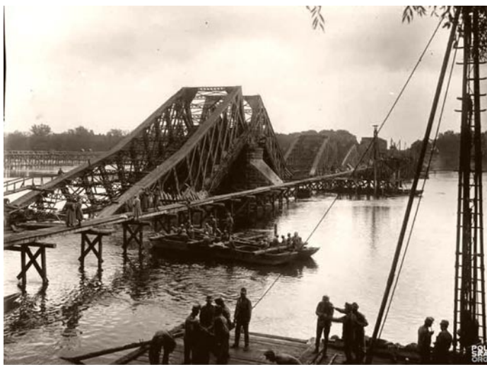
Zburzony most kolejowy na Wiśle 1915 r.
