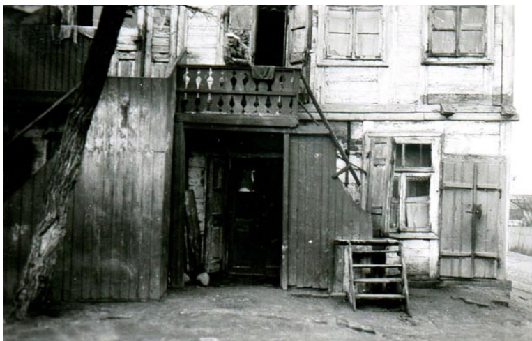
Irena – zabudowania tuż przy lotnisku
