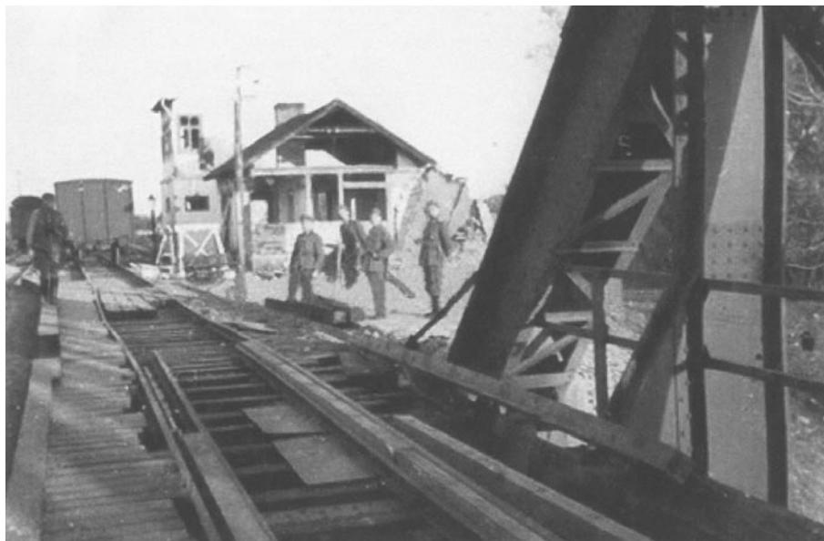
Uszkodzone budynki kolejowe, tory świeżo naprawione po próbie uszkodzenia mostu na Wieprzu przez Oddział „Błyska”.
